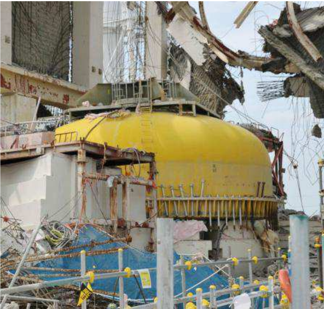
Le couvercle entièrement dénudé de l'enceinte de confinement du réacteur.
