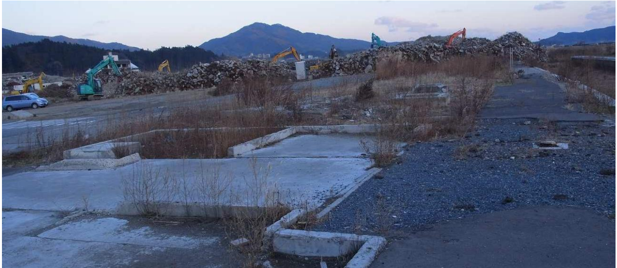
La gare de Rikuzen-Takada. On voit les collines de débris.
