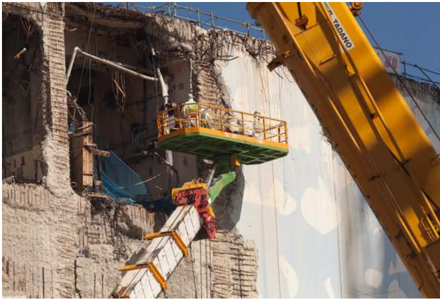
Des ouvriers coupent et détachent les ferrailles d'un bâtiment.
